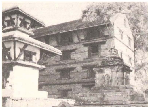
Fig. 1-2-1. Chaitya, Nuwakot Darbar
